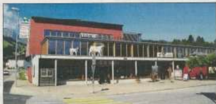
So sieht der heutige Standort des «Maison du Gruyère» aus. Der Abbruch ist für 2022 geplant. (MML AG)
